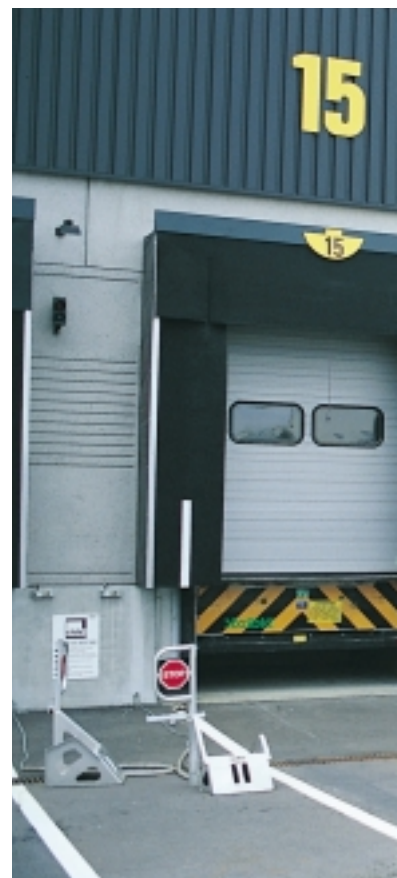
Quai de chargement-déchargement d'une plate-forme logistique.
