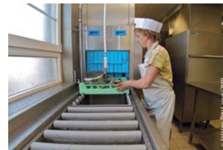
L'espace consacré à la plonge est également plus vastes et une nouvelle laveuse qui peut recevoir jusqu'à quatre paniers en même temps a été installée.
