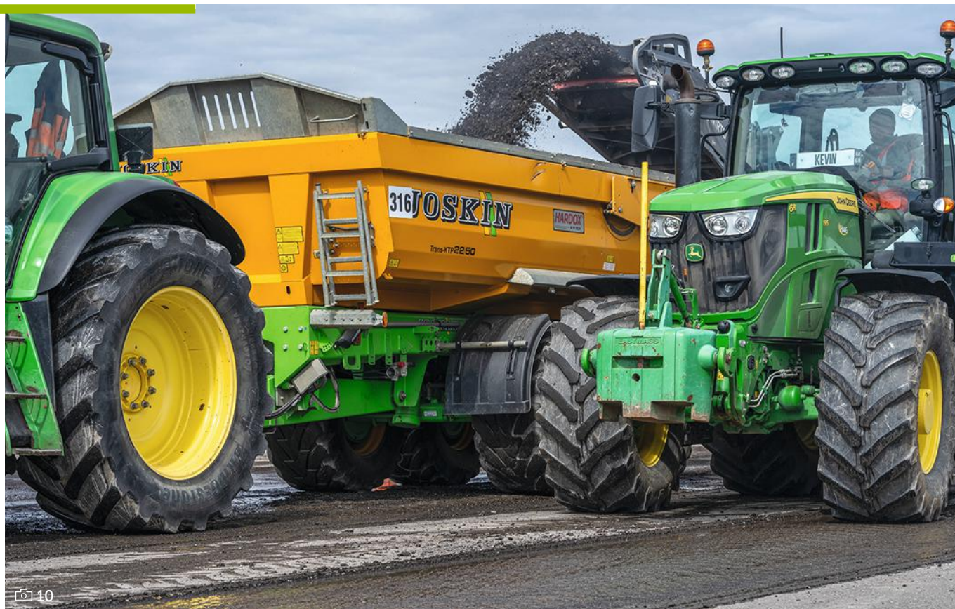
10. SUR LE TAXIWAY , la voie qui mène à la piste, la coactivité est intense : se croisent des raboteuses pour décaper l'enrobé, des tracteurs qui remorquent les débris, des niveleuses et des compacteurs à billes.
