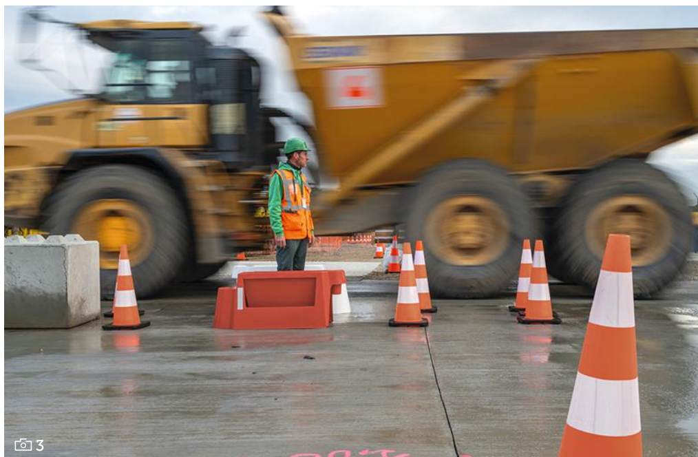
3. UN HOMME TRAFIC régule les entrées et sorties de la zone de déchargement des tombereaux. Une présence nécessaire pour limiter les risques de heurts, d'autant que le carrefour est situé à proximité du parking de la base vie.
