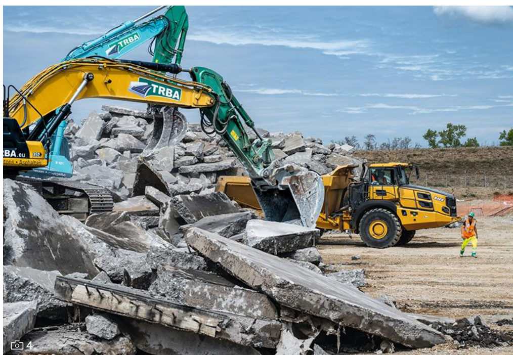
4. L'EMPLACEMENT de la zone de dépôt des matériaux collectés a été pensé en amont : elle a été aménagée dans un endroit à part, derrière la centrale à béton, pour l'heure à l'arrêt, afin d'éviter au maximum les croisements de flux.
