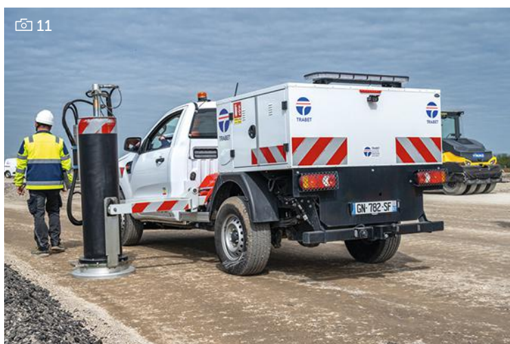
11. LA PRESSION du compactage de cette voie, destinée à supporter des avions de plus de 40 tonnes, est vérifiée automatiquement grâce à un engin conçu sur mesure.
