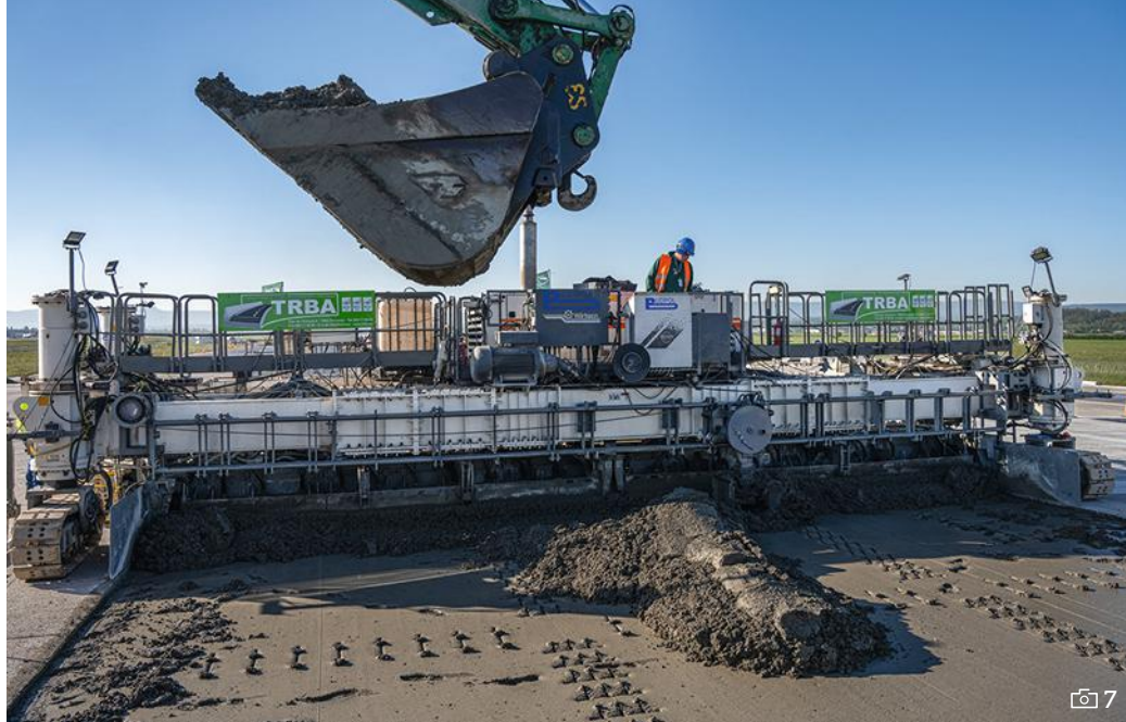
7. TROIS FINISSEURS de 12 m de large permettent d'appliquer une couche de 38 cm de béton. La machine de tête quadrille le revêtement de goudjons métalliques, destinés à assurer le transfert de charges entre les dalles et prévenir les fissures de dilatation thermique.
