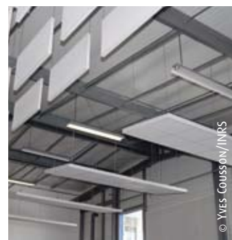
396 baffles suspendus ont été installés et disposés de façon à préserver l'éclairage zénithal.
