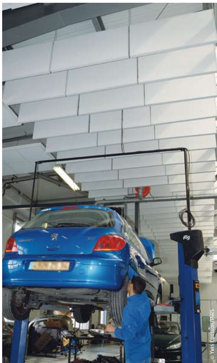
396 baffles suspendus ont été installés et disposés de façon à préserver l'éclairage zénithal.
